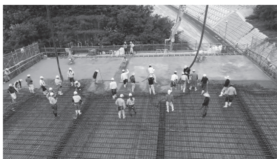
写真 - 10 上床板コンクリートの打込み状況
