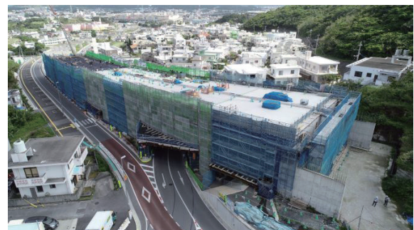
写真 - 8 支保工全景
