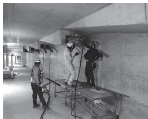
写真 - 2 箱桁内緊張状況
