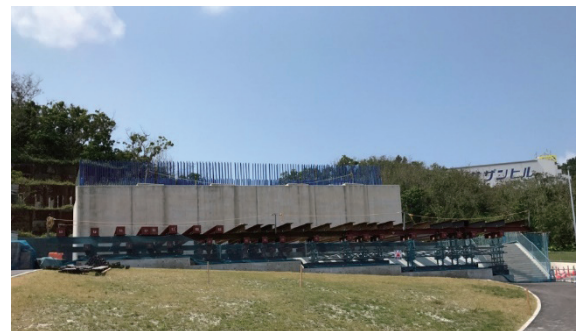
写真 - 6 階段形状基礎 (UDA2 前面)
