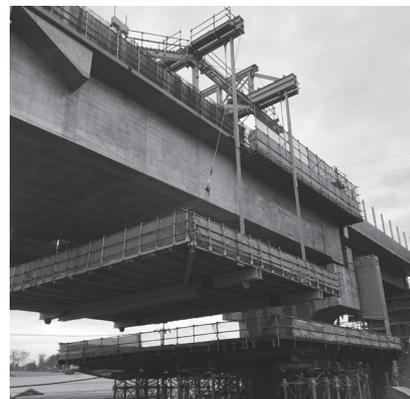
写真 - 8 側径間支保工上での移動作業車解体
