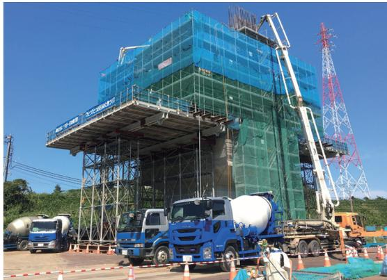
写真 - 1 移動作業車部材を使用した柱頭部支保工
