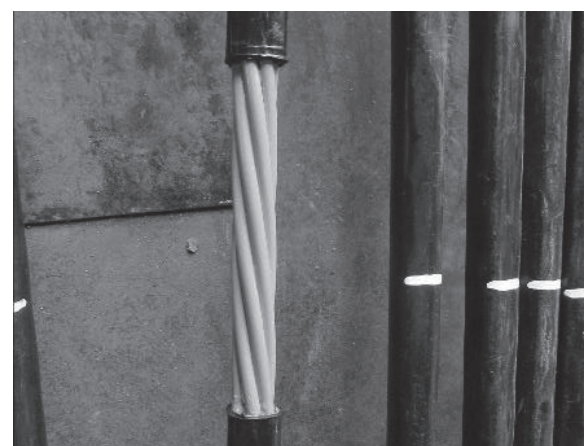
写真 - 6 疲労試験後のPE被覆内部 (試験材番号 S2)
