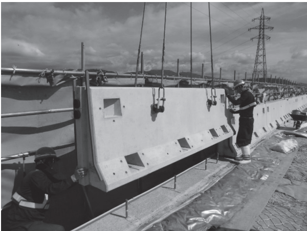
写真 - 7 プレキャスト壁高欄の施工状況
