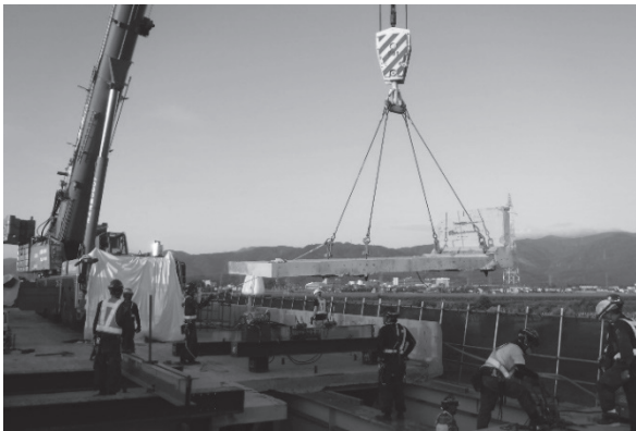
写真 - 2 床版撤去状況
