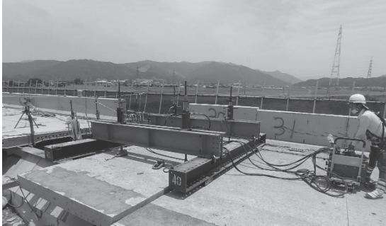
写真 - 1 床版の引き剥がし状況
