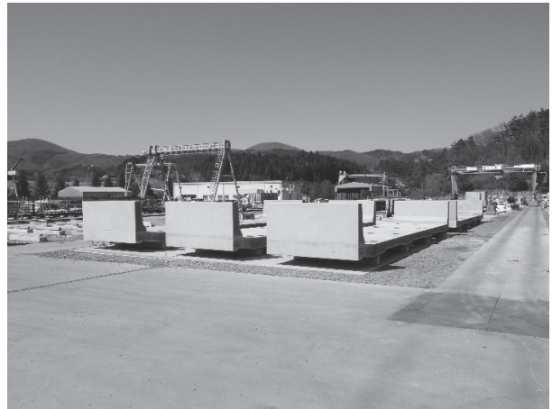
写真 - 8 工場での壁高欄製作状況
