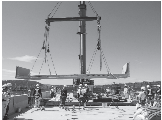
写真 - 4 クレーンによる床版架設状況
