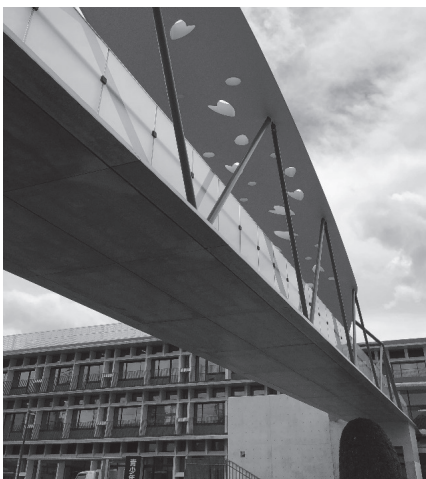
写真 - 17 連絡橋見上げ
