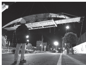
写真 - 16 連絡橋架設
