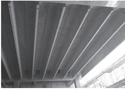
写真 - 5 ST床版架設状況, 断面図
