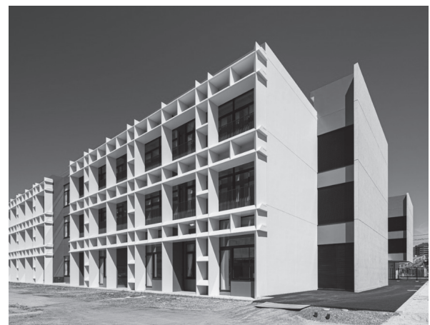
写真 - 18 校舎南面外観
