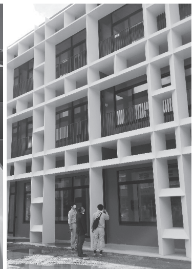
写真 - 14 建て方後のフィーレンディール架構
