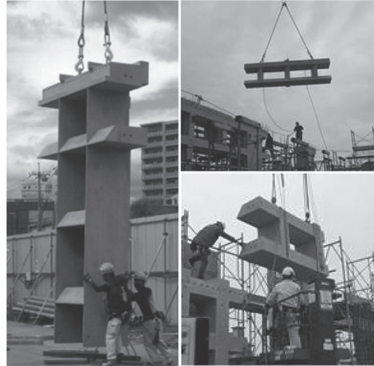
写真 - 13 フィーレンディール架構の架設状況
