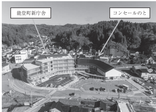
写真 - 1 新庁舎と周辺状況
