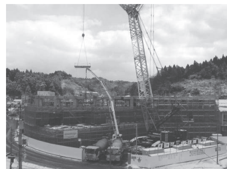
写真 - 5 架設状況
