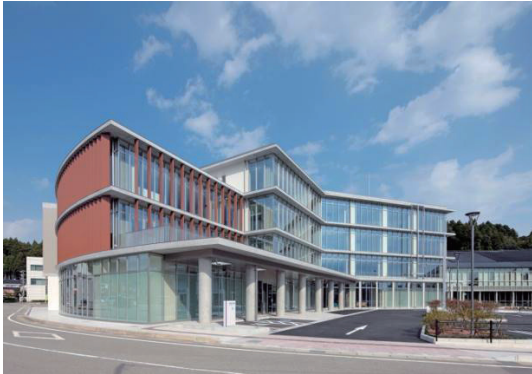
写真 - 6 建物外観
