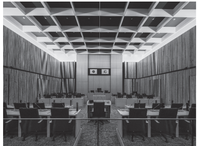
写真 - 3 鉄骨格子フレームの議場屋根
