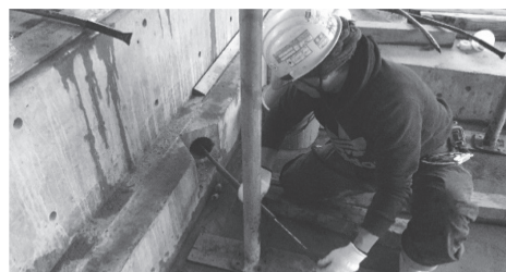
写真 - 8 ジャッキスペースの確保
