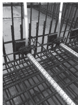
写真-12 PCキャンチスラブの配線状況 (左：固定定着具、右：緊張定着具)
