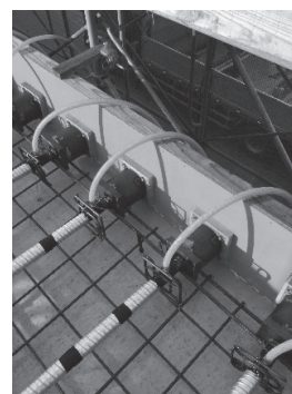
写真-12 PCキャンチスラブの配線状況 (左：固定定着具、右：緊張定着具)
