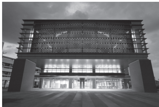
写真-1 西側ファサード
