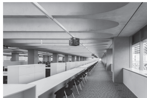
写真 - 3 執務室の曲面 PCaPC 床板
