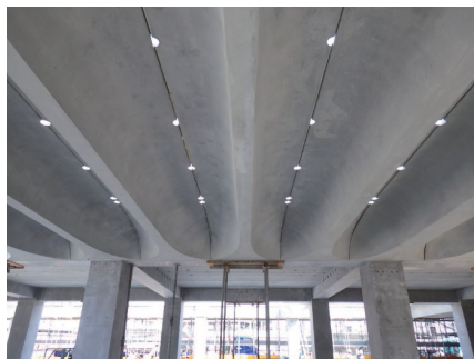
写真-10 床板の支保工
