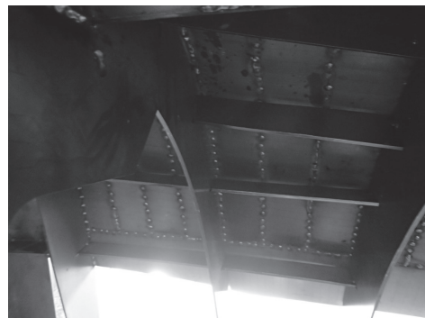
写真 - 7 型枠のリブ配置
