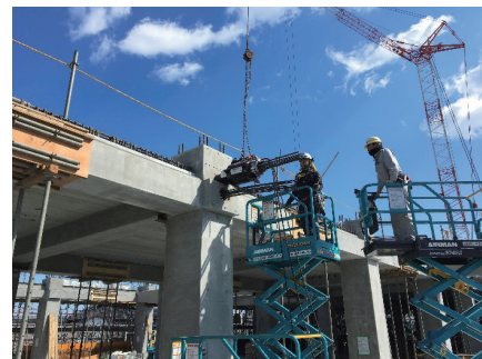
写真-11 立会い時2次緊張(B-C間)
