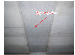
床版下面の様子
