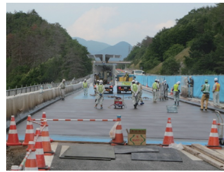
写真 - 1 床版取替え実施例 写真 - 2 光ファイバー
