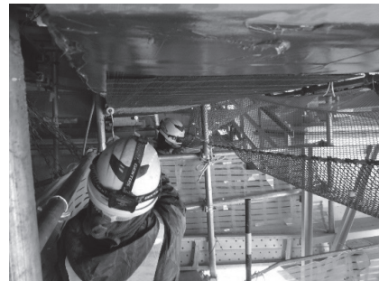
写真-12 炭素繊維ストランドシート設置状況
