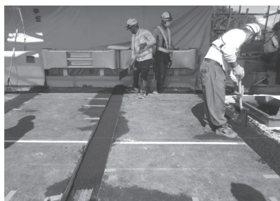
写真 - 5 仮舗装状況
