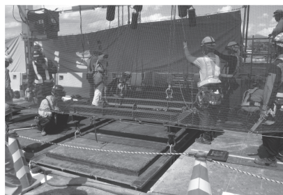
写真 - 4 仮設床版設置状況
