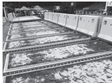
写真-2 PCaPC床版への壁高欄の事前施工と事前防水
