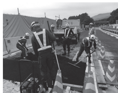
写真 - 9 舗設状況
