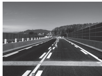
写真-13 施工完了
