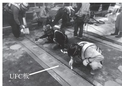
写真 - 7 UFC板設置状況
