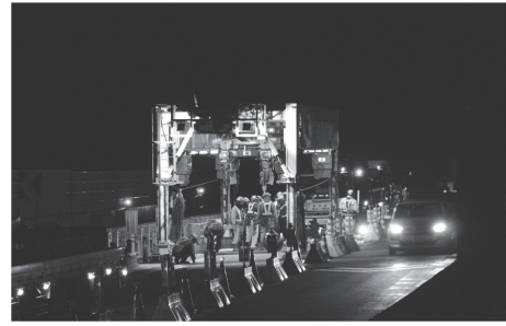
写真-1 施工状況写真
