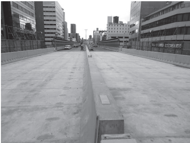
写真 - 7 床版・壁高欄の施工完了状況
