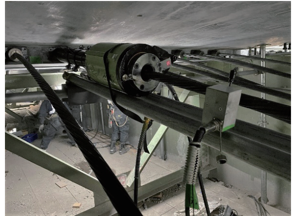
写真 - 5 交差差着部の緊張状況
