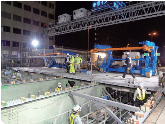
写真 - 4 専用架設機による床版架設状況
