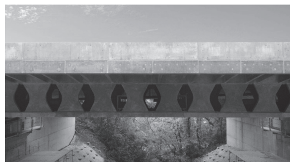
写真 - 9 別埜谷橋 (上流側から)
