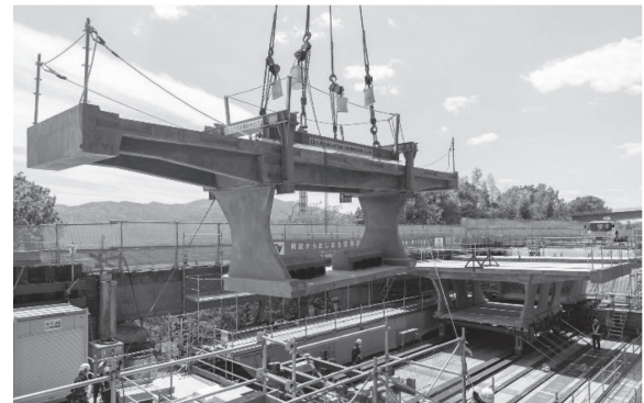
写真 - 3 セグメント送出し架設
