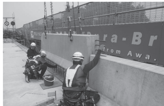
写真 - 5 超高耐久プレキャスト壁高欄の架設
