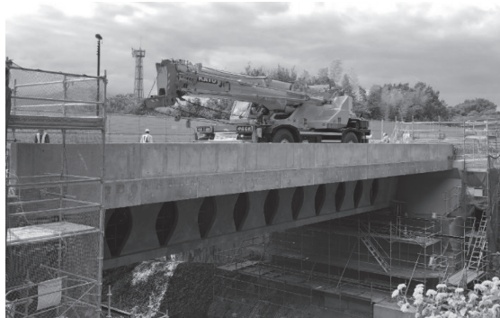
写真 - 6 車両載荷試験
