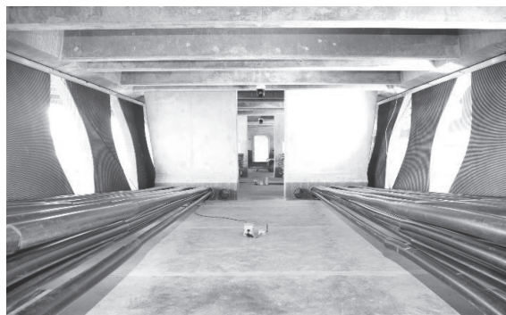
写真 - 8 バタフライウェブ構造の桁内照度
