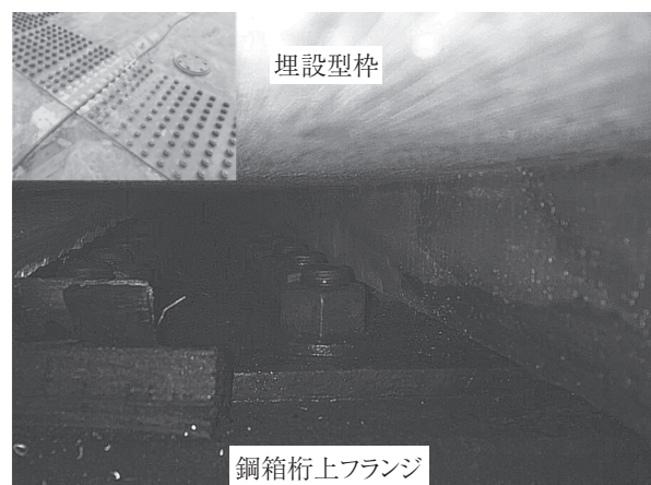
写真 - 3 鋼箱桁上フランジ確認状況 (CCD)
