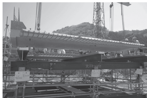
写真 - 6 施工性試験状況
