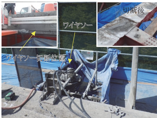
写真 - 10 既設床版撤去状況（水平切断）
