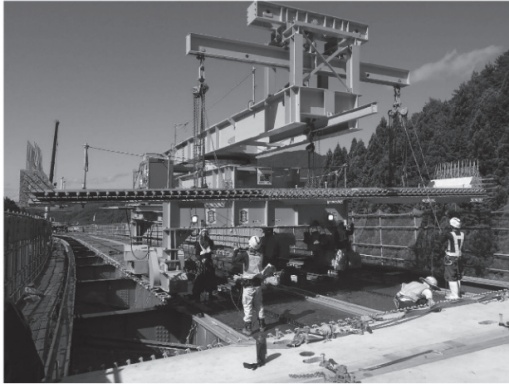
写真 - 4 橋上架設機による架設状況
