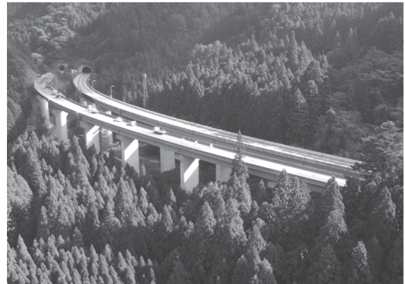
写真 - 1 常国橋（全景）
