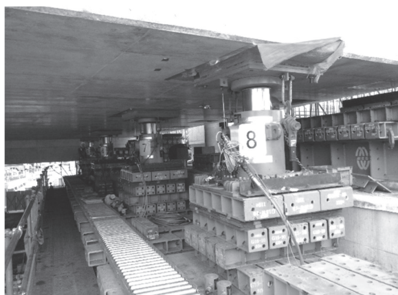
写真 - 5 ジャッキダウン施工状況
