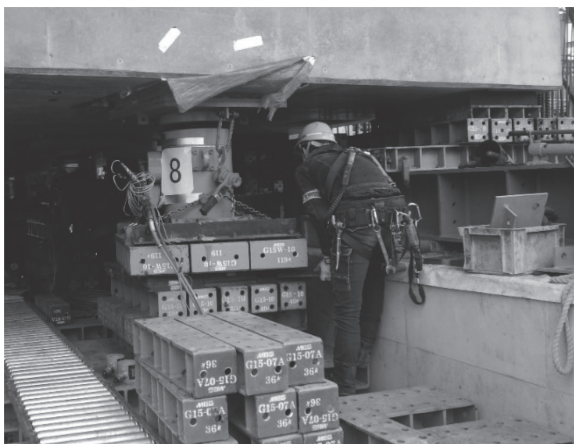
写真 - 2 500 tf ジャッキの設置状況
