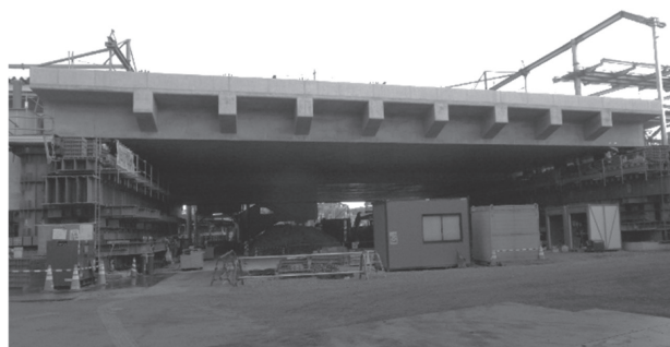
写真 - 1 折尾高架橋全景
