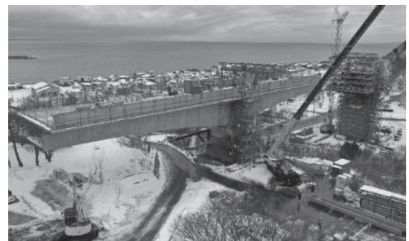
写真 - 2 現場状況
