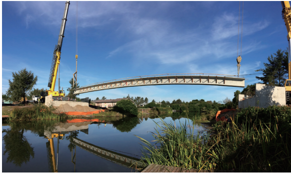
図 - 1 プレキャンバー桁の架設状況
