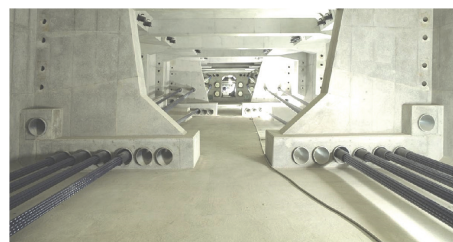
写真 - 8 的場高架橋の箱桁内の状況
