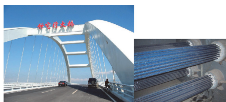
写真 - 11 アモイ海洋公園橋と箱桁内の外ケーブル
