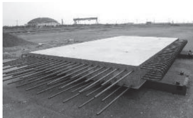
写真 - 27 プレグラウト PC 鋼棒が適用された PC 床版
