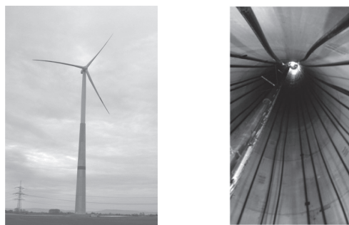
写真 - 23 ドイツの風力発電タワーと内部の外ケーブル 10)
