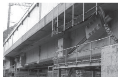
写真 - 18 PC 桁の外ケーブル補強の例
