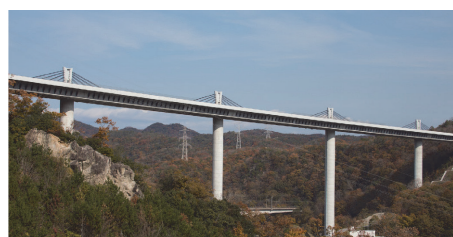
写真 - 9 武庫川橋
