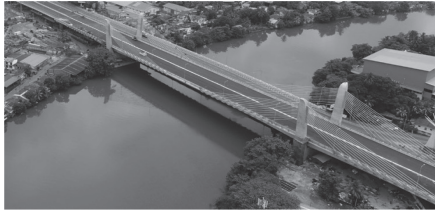
写真 - 12 スリランカのケラニ河新橋
