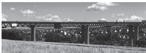
写真 - 19 鉄道橋の鋼トラス桁の外ケーブル補強 10)
