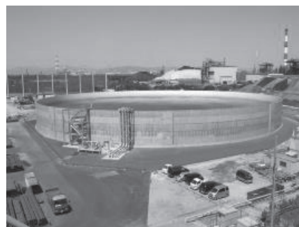
写真 - 25 タンクへの高強度 ECF ストランドの適用例
