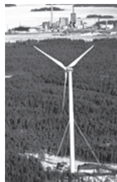
写真 - 24 鋼製タワーの斜ケーブルによる補強例 10)
