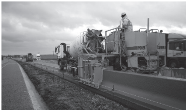
写真 - 26 防護柵の補強筋への ECF ストランドの適用例
