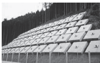
写真 - 20 法面補強への適用例
