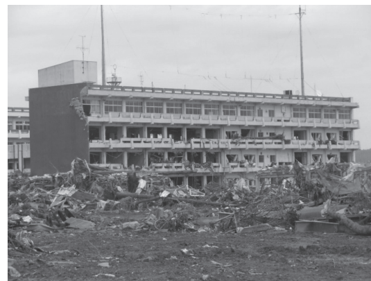
写真 - 3 津波で被災したRC造学校校舎
