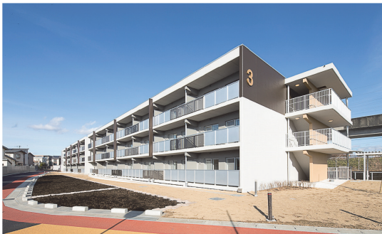
写真 - 5 県営南青山アパート（岩手県盛岡市 99 戸）
