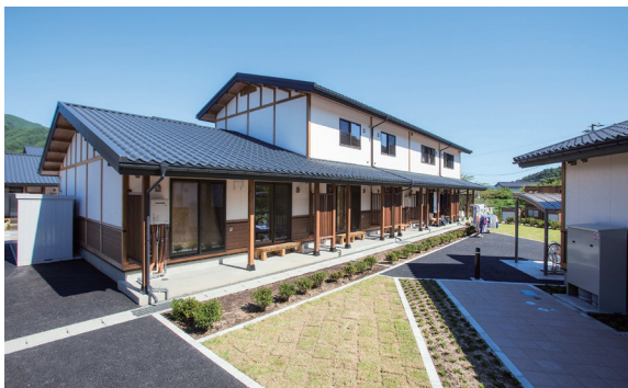
写真 - 6 大ケ口一丁目町営住宅（岩手県大槌町 70 戸）
