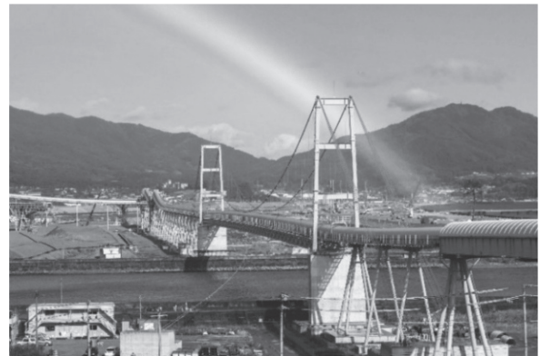
写真 - 1 気仙川を渡るベルトコンベア
