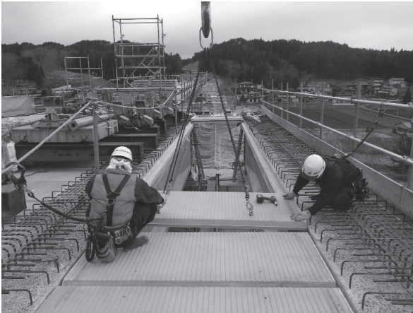
写真 - 2 PC 板敷設状況
