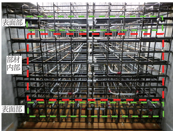
写真 - 12 クーリングパイプ設置
