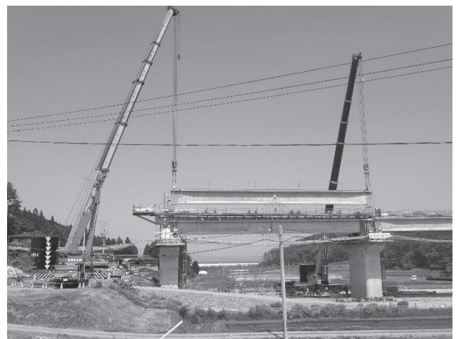
写真 - 1 主桁架設状況
