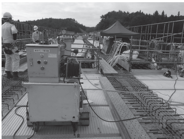
写真 - 8 真空グラウト工法
