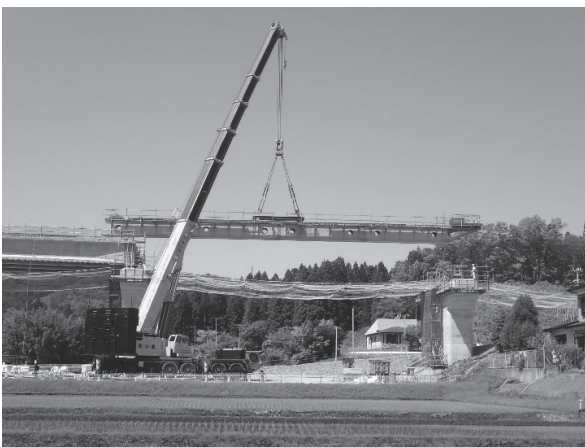
写真 - 3 架設桁移動状況
