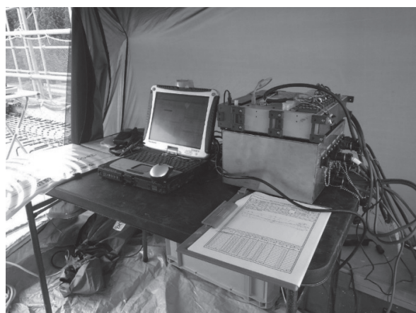
写真 - 9 グラウト管理計測状況
