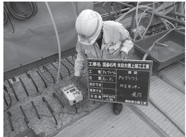
写真 - 10 充填検知センサー
