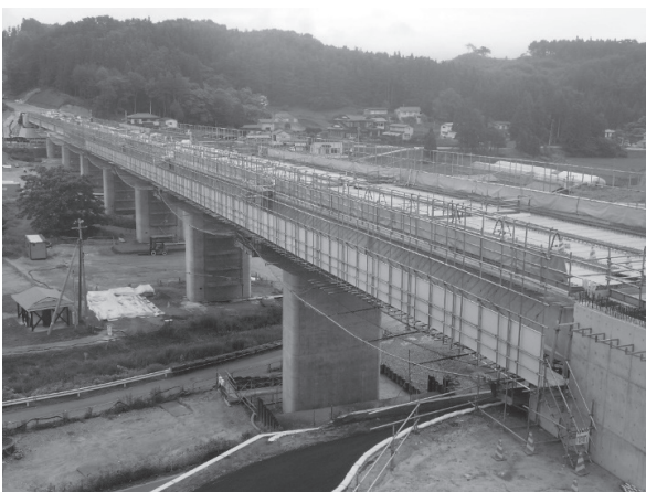
写真 - 4 主桁架設完了
