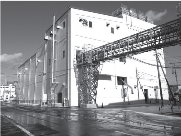
写真 - 15 建物外観
