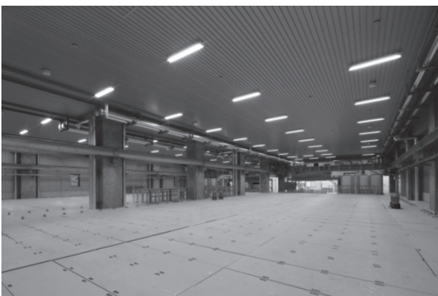
写真 - 16 建物内観
