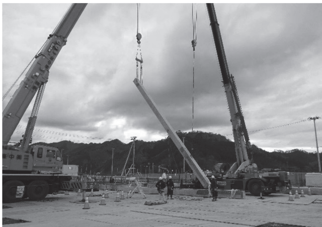
写真 - 7 柱建て起こし状況
