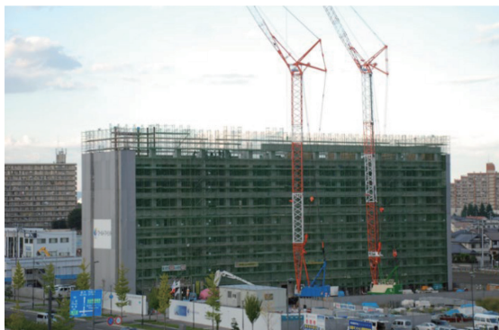
写真 - 2 施工状況
