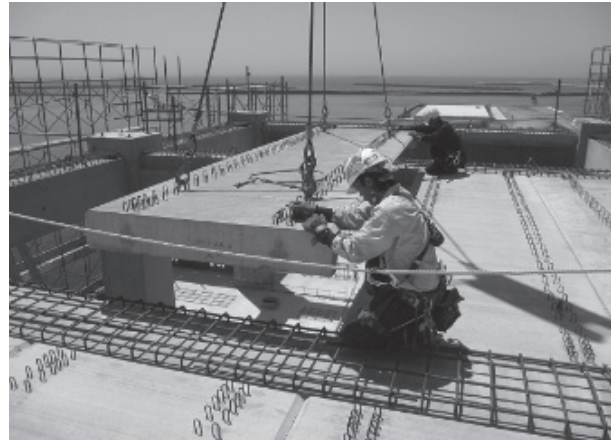
写真 - 18 PC 版架設状況
