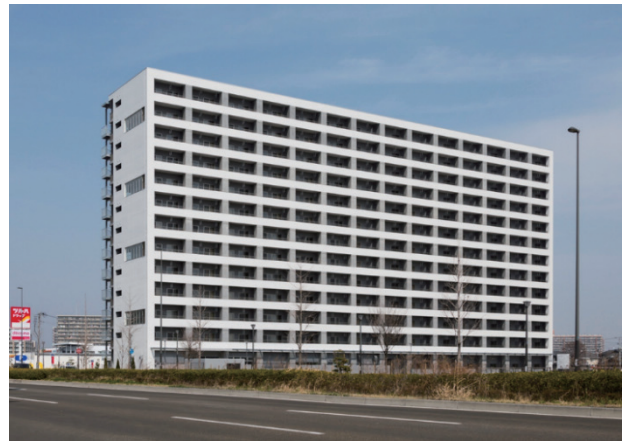
写真 - 3 建物外観 (撮影: エスエス東京)
