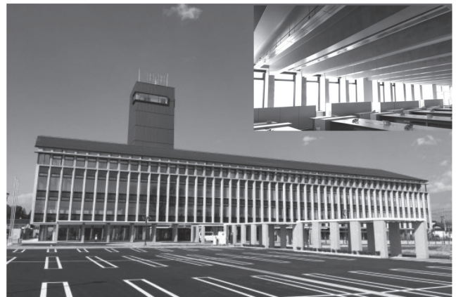
写真-5 建物外観および執務スペース内観
