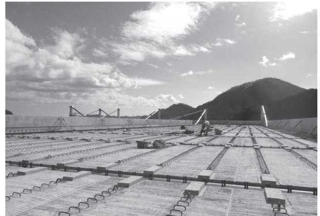
写真 - 21 施工状況
