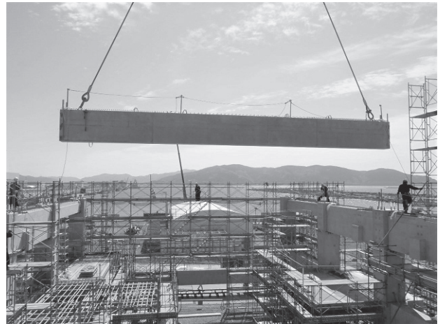
写真 - 13 架設状況
