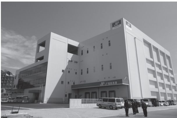
写真 - 11 建物外観
