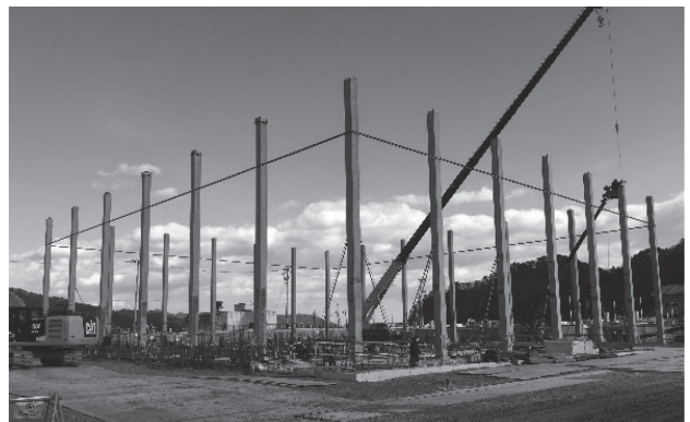
写真 - 9 建て入れ完了
