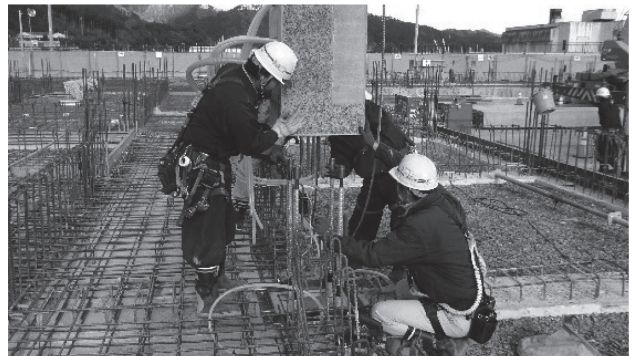
写真 - 8 柱架設状況
