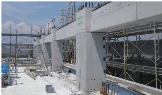
写真 - 1 施工状況
