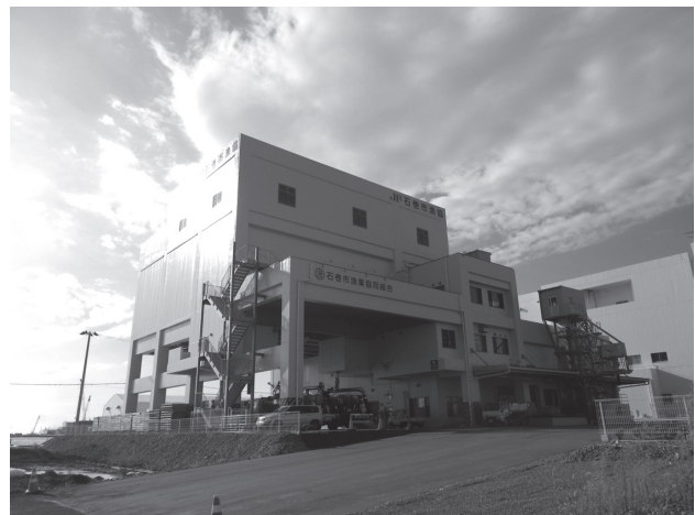
写真 - 14 建物外観
