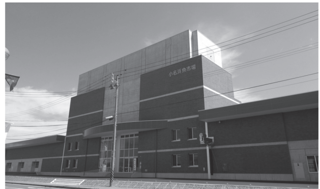
写真 - 19 建物外観
