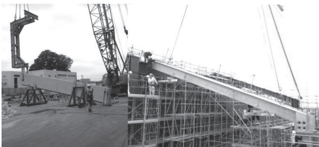
写真-4 柱・ST床版施工状況
