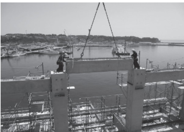
写真 - 17 梁架設状況
