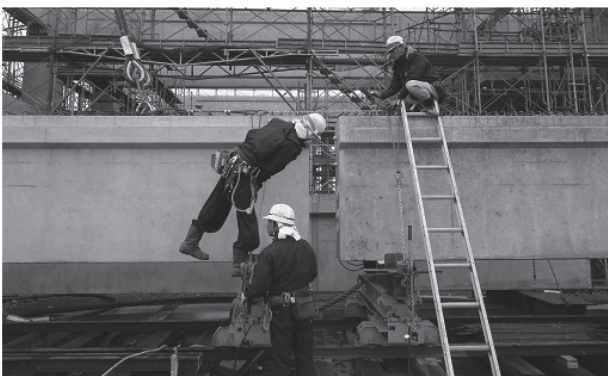
写真 - 12 梁連結状況
