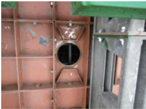
写真 - 7 バイブレーター挿入孔
