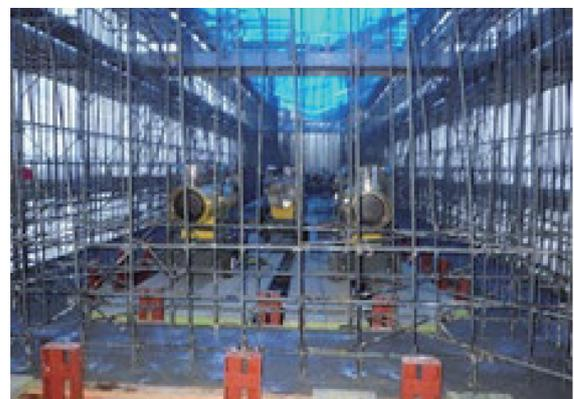
写真 - 12 給熱養生状況
