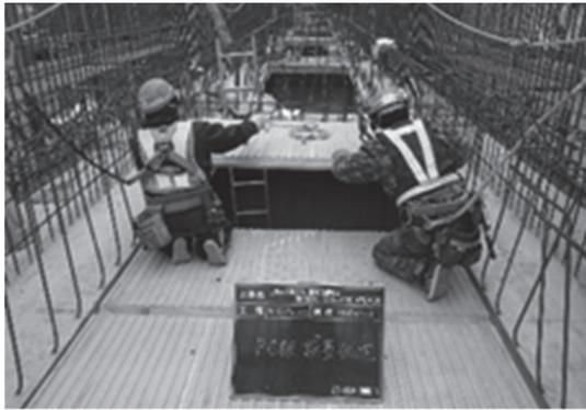
写真 - 2 PCaPC 板設置状況
