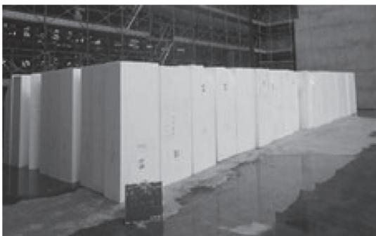
写真 - 4 ブロック埋設型枠
