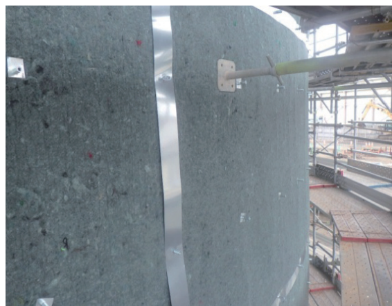
写真 - 2 緩衝材の設置
