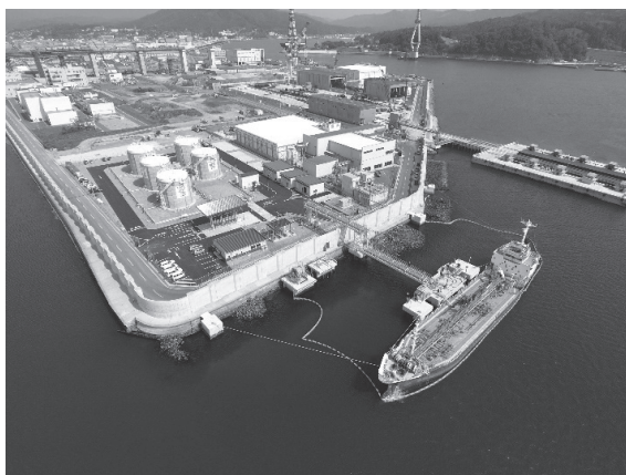
写真 - 3 再建された燃油施設の全景
