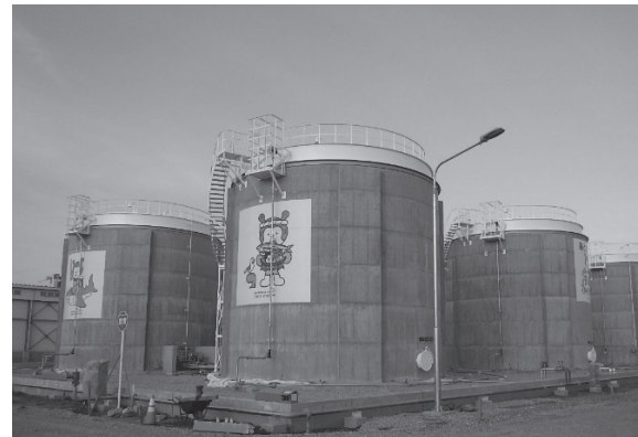
写真 - 4 津波対応型燃料タンクの全景
