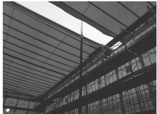
写真 - 8 雪寒仮囲い屋根のスライド式開閉構造の例<sup>7)</sup>
