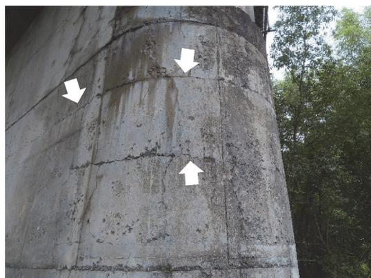
写真-1 コンクリート橋脚の打重ね線に沿ったひび割れ
