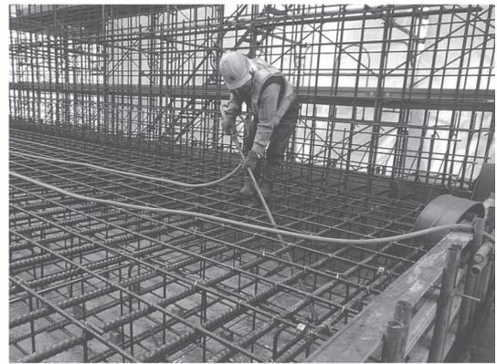
写真 - 7 エアーコンプレッサによる型枠内部の清掃<sup>7)</sup>
