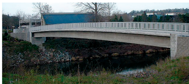
図 - 11 Interurban Trail 歩道橋
