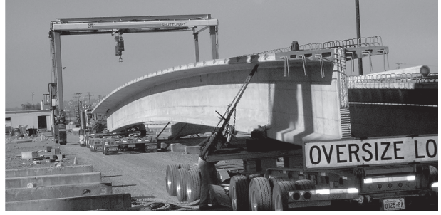
図 - 10 運搬準備中のプレキャンバー桁
