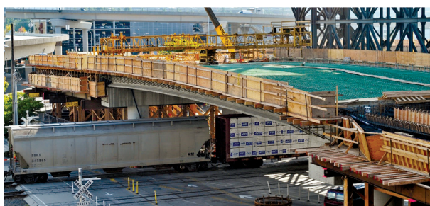
図 - 12 州道 519 号 Royal Brougham 橋
