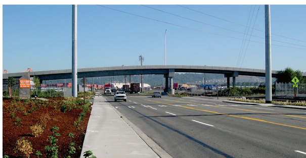
図 - 13 Marshall Avenue 橋
