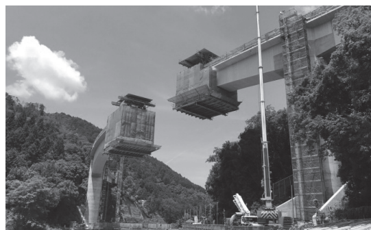
写真-5 片持ち架設
