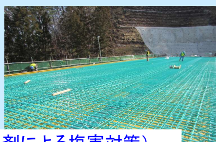
橋梁床版 (凍結防止剤による塩害対策)
