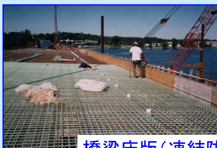
橋梁床版 (凍結防止剤による塩害対策)
